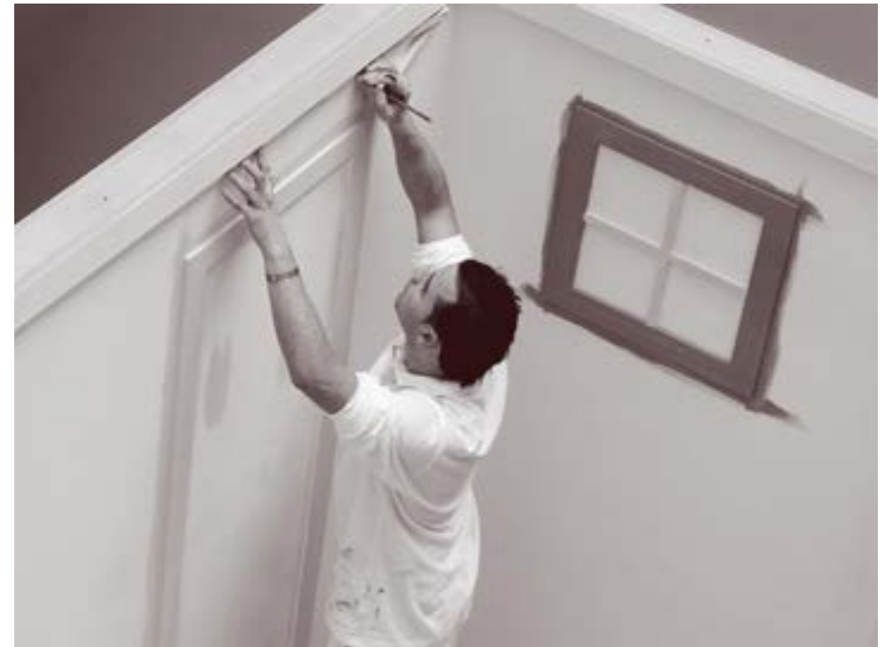
Ständig angehobene Körperteile, z.B. Arme → anpassen der Arbeitshöhe
